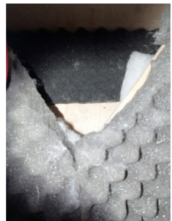
Innenansicht TML- V-Übergang oben
